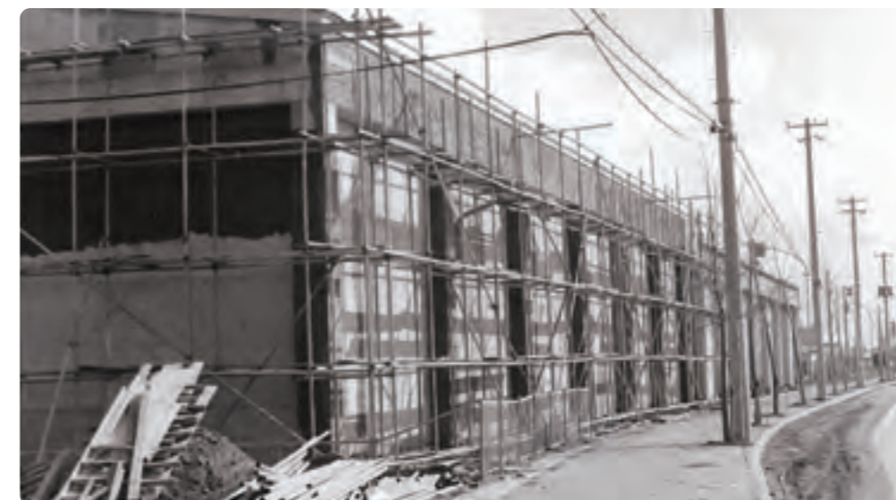
東部幹線から撮影した第2期工事の様子
