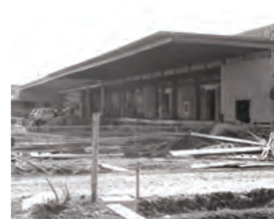
第2期工事中の富久山冷蔵庫
