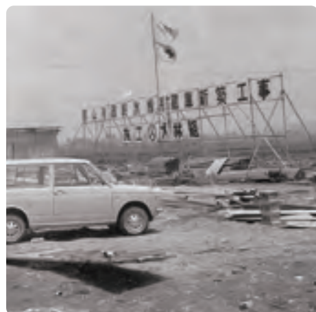
富久山ののどかな景観の中、新築工事施工の 看板が目をひいた
