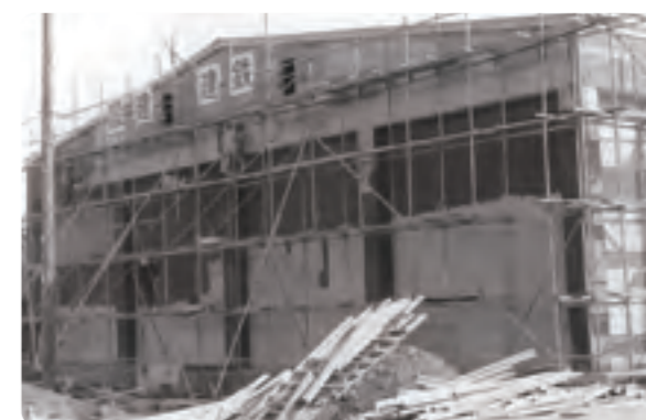
富久山冷蔵庫のさらなる増設のため第3期工事に着手
