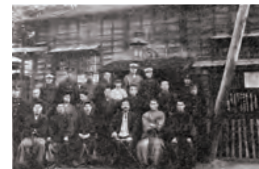
改築中の仮局舎
