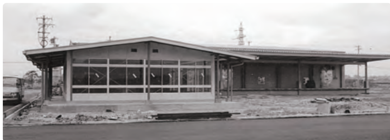
第1期工事、完成間近の様子
