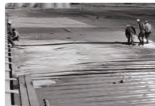
第2期工事中の屋根より富久山陣場方面を望む
