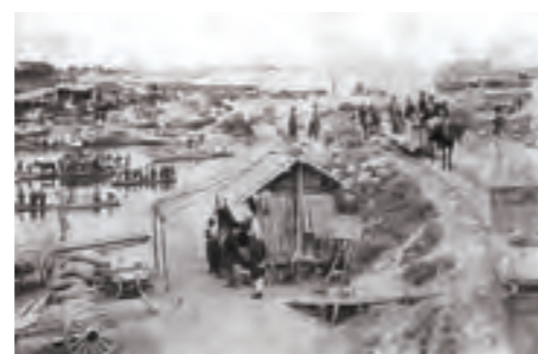
水害後の馬車鉄道の光景 (後方に磐越東線阿武隈川鉄橋工事中の橋脚が見える)
