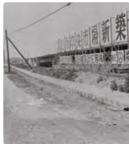
建設中の郡山市中央市場
