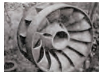
三春に初めて電灯をつけた 滝発電所のタービン
